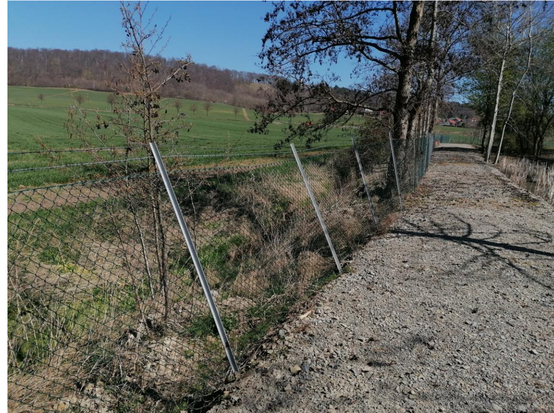
Zaunanlage bei ca. Station 1+025, Blickrichtung stromaufwärts
