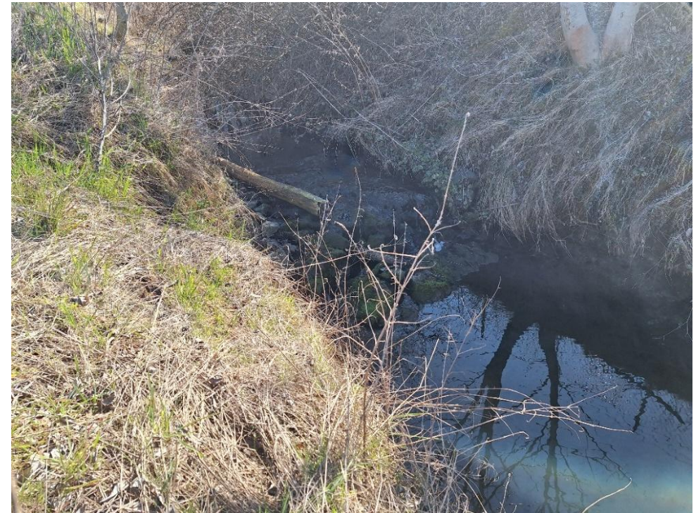
Sohlabsturz bei ca. Station 1+115
