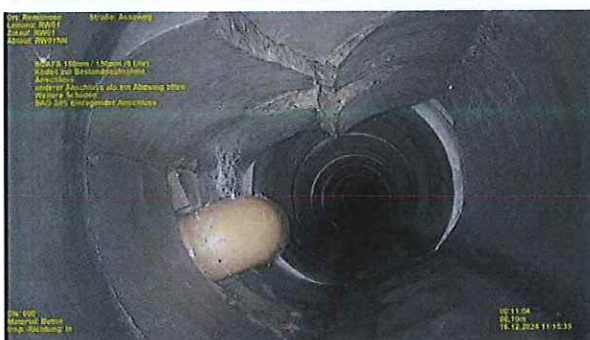
Foto 4 Scherbenbildung - Einsturzgefahr
